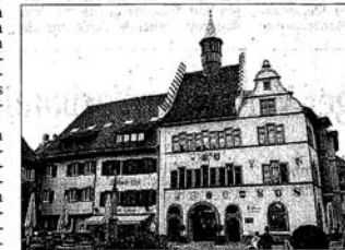
Am Rathaus von Staufen (1) und an 120 Häusern haben sich große Risse gebildet (r.). Grund könnten nach Expertenmeinung Geothermiebohrungen sein, die 2007 durchgeführt wurden, um das Rathaus mit Erdwärme zu heizen. Fotos: dpa/AP
