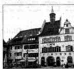
Am Rathaus von Staufen 13 sind es 120 Höhenmeter, die sich im Laufe der Jahre abgesenkt haben. Die Ursache für die Schäden ist die Absenkung des Grundwasserspiegels.
